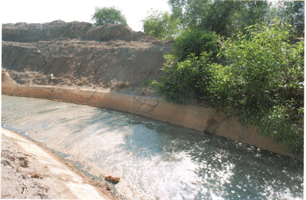
รูปที่ ๗ แผ่นคอนกรีตรางระบายน้ำ ๑๐ แผ่น
