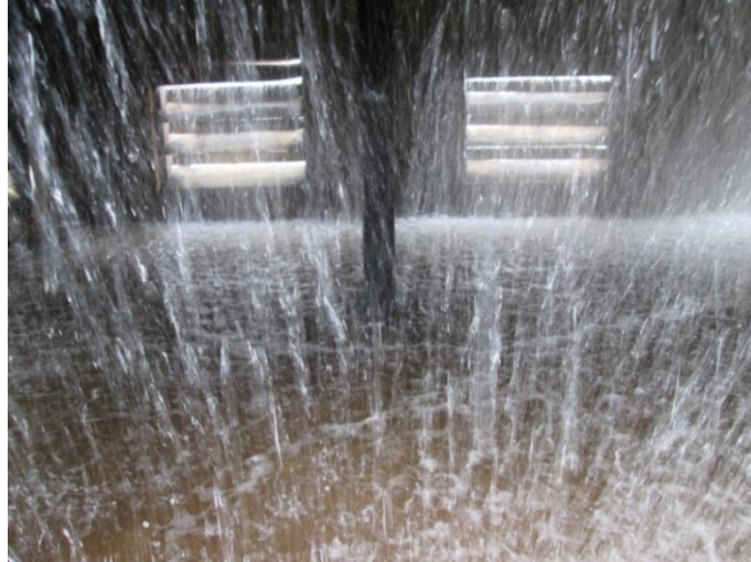
รูปที่ หอผึ่งเย็นที่ใช้ในกระบวนการกลั่นแอลกอฮอล์บริสุทธิ์ที่มีการกระจายเพียงบริเวณขอบโดยรอบเท่านั้น
