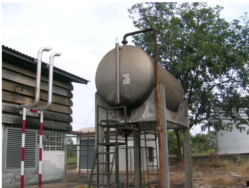
ถังเชื้อเพลิง (ดีเซล) สำหรับเครื่องกำเนิดไฟฟ้า
